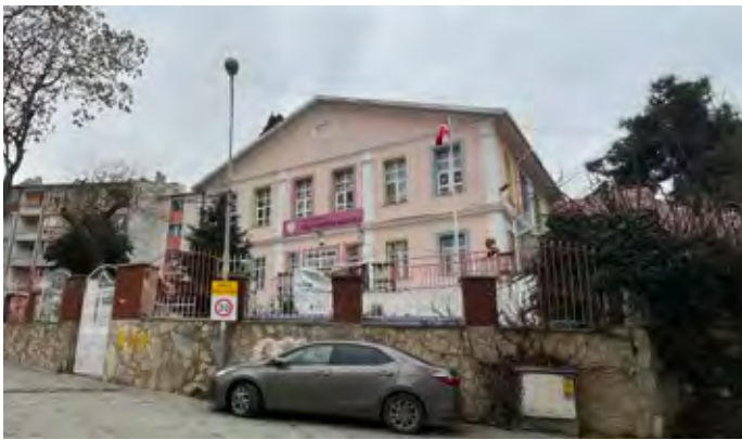
Resim 12-13. Güney cephesi ile doğu ve kuzey cepheleri.
