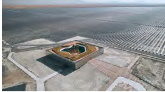
Karapınar GES Merkezi Kontrol Binası
