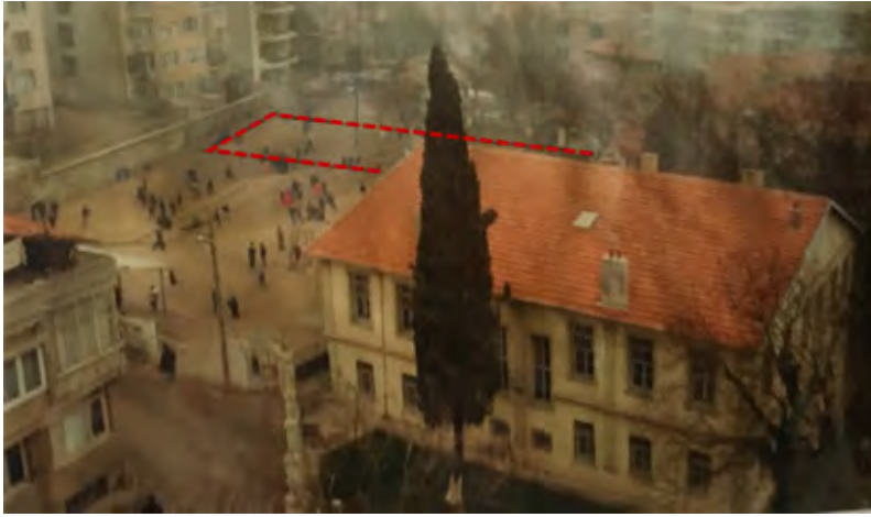
Resim 11. Süleymanpaşa İlkokulu batı cephesi, 1990-91, işaretli yer yeni betonarme okulun yapılacağı alanı göstermektedir.
