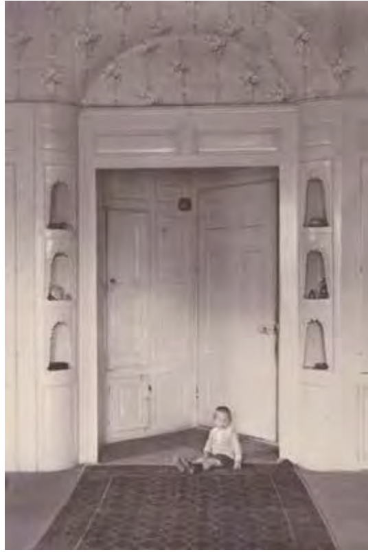
Resim 6. Çalışma odasının girişi. Gömme dolapların köşelerindeki nişlerdeki ince işçilik ve giriş kemerinin duvar kâğıdıyla örtülmüş oluşu, konağın oldukça zengin bir ahşap işçiliğine sahip olduğuna işaret etmektedir. Duvar kâğıdı olasılıkla 1915 yılından kısa bir zaman önce yapılmış bir yenilenme sırasında döşenmiş olmalıdır (Penck Aile Arşivi).
