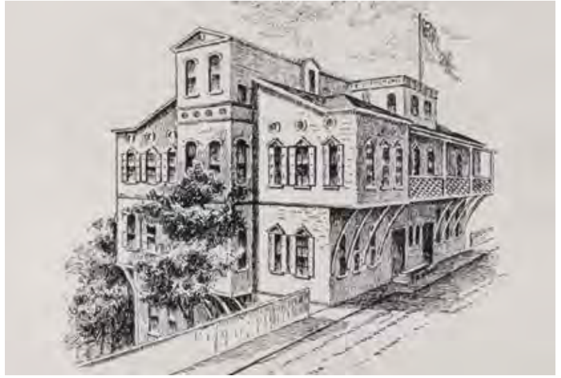
Resim 2. Bebek Ruhban Okulu'nun olasılıkla 1840'lı yıllardaki görünümü. Benzer bir bakış açısıyla 1916 yılında çekilmiş olan fotoğrafla (Şekil 5) karşılaştırıldığında, binada daha sonraki yıllarda bazı tadilatların yapıldığı anlaşılmaktadır.
