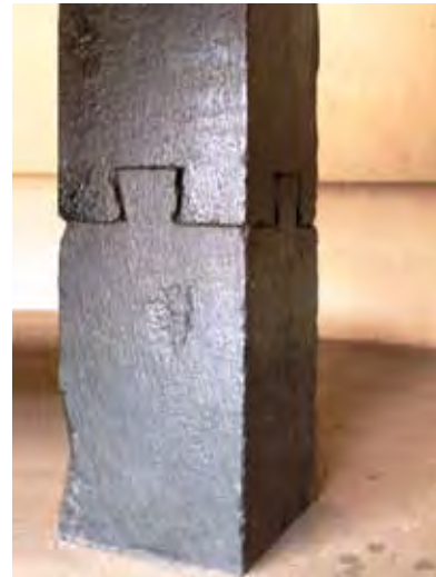
Resim 4. Kirlangıçkuyruğu birleşim tekniğiyle taş kolon örneği, Vazhappally Maha Siva Tapınağı, Hindistan (Kaynak: RajeshUnuppally at Malayalam Wikipedia).
