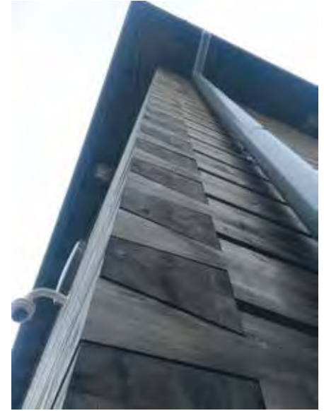
Resim 3. Kirlangıçkuyruğu duvar birleşimleri (Pudasjärvi okul kampüsü, Finlandiya).
