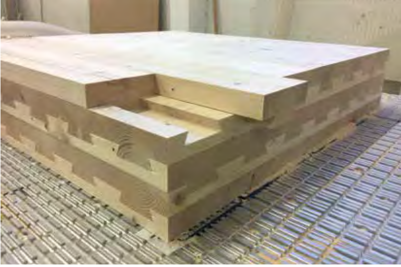
Resim 8. Kırlangıçkuyruğu ahşap panel eleman
