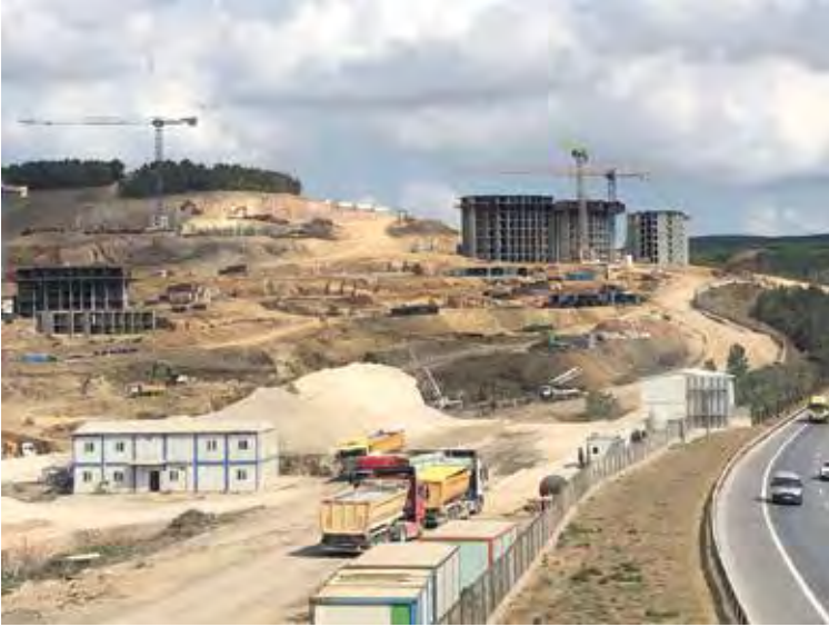
Resim 3. Maltepe Baransel Kışlası Askeri Alanı'nda yapılan müdahalelerden görünüm.
