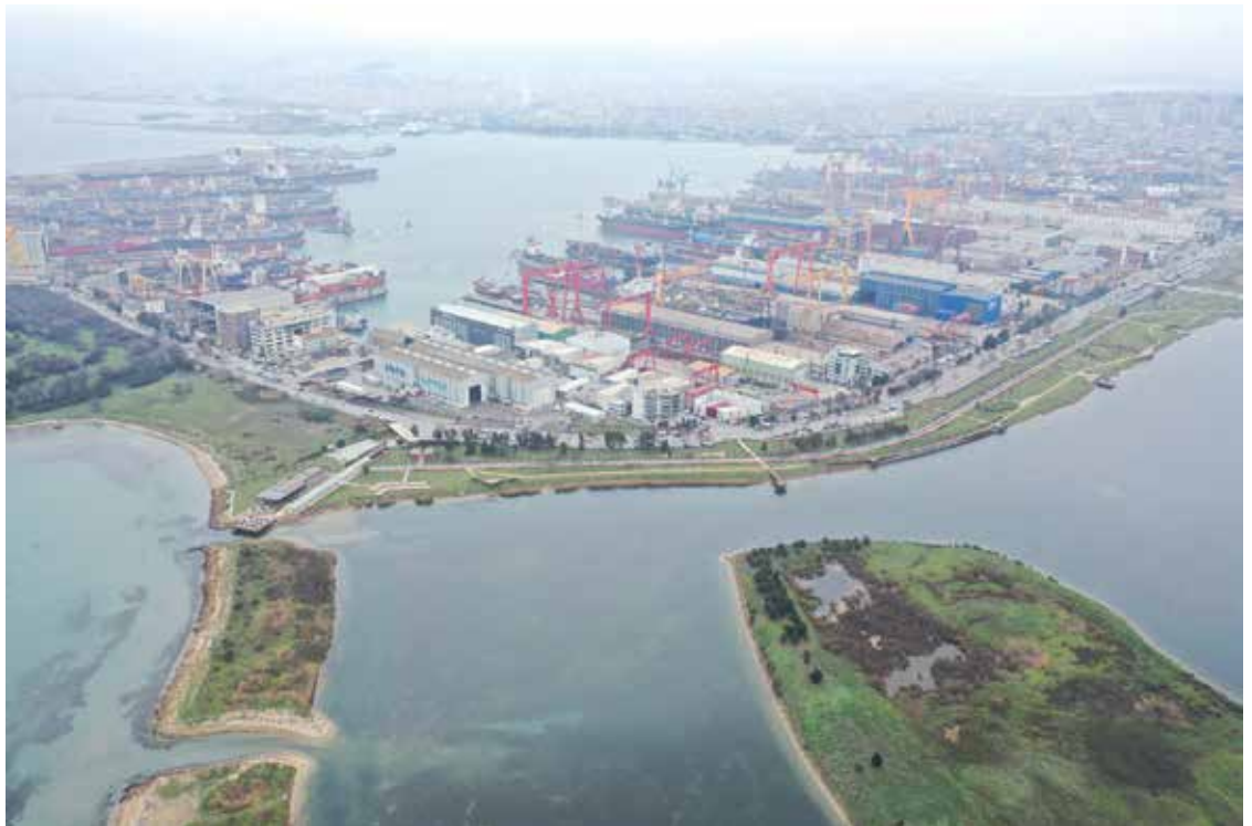
Resim 4. Tuzla Tersaneler Bölgesi'nden görünüm.
