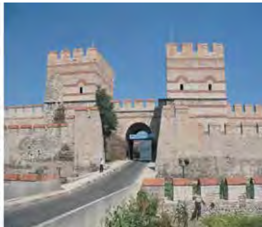
Resim 6. İstanbul Kara Surları, Belgrad Kapı, 19. Yüzyıl sonunda Sebah-Joallier fotoğrafında ve pilot proje uygulaması sonrası 1990’larda görülmektedir.
