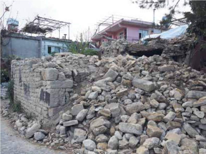
Şekil 12. Hatay, Samandağ, Hıdırbey Köyü'nde yıkılmış taş yapı.
