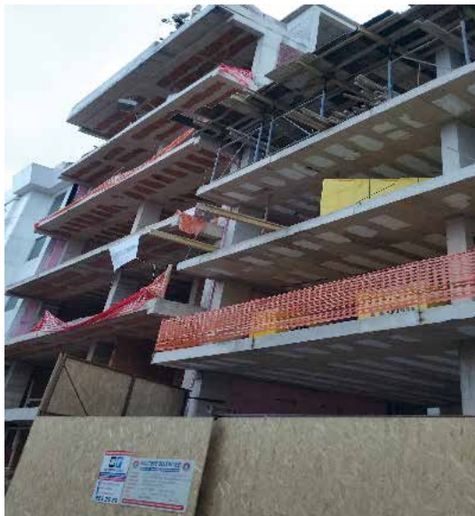
Resim 7. Komşu katlar arası döşeme seviyesi farkı, çekileme etkisine örnek (İstanbul).
