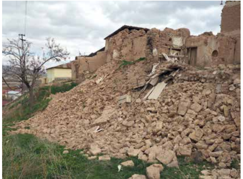
Resim 9-10. Malatya Balaban'da yıkılmış kerpiç yapılar.
