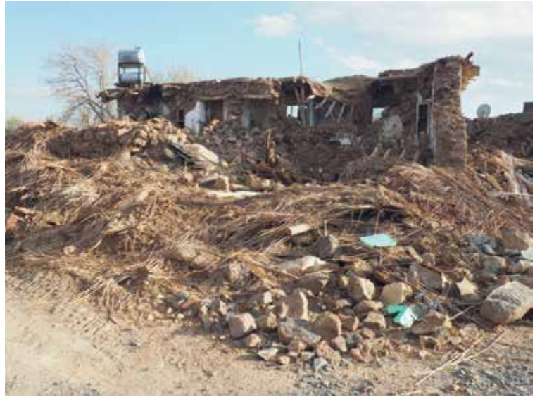
Şekil 13. Gaziantep, İslahiye, Zincirli Köyü’nde yıkılmış taş yapı.
