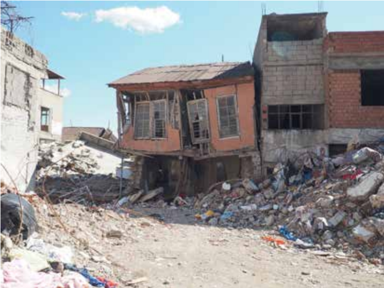
Resim 7-8. Kahramanmaraş merkezde bir ev.
