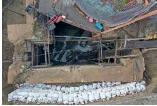
Resim 8. İbrahimağa bölgesi manevra alanındaki T planlı yapı.
