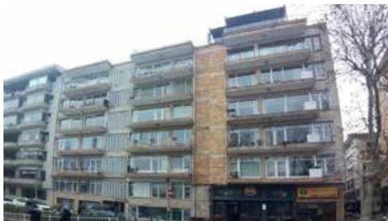
Resim 5. Moda'nın 1960'lar temsilcileri. Sırasıyla; Bekir İhsan Ünal tasarımı Akgün Apartmanı, Melih Koray tasarımı Aylin Apartmanı, Gayyur Tezcanlı tasarımı Ufuk Apartmanı ve Hayri Aybar tasarımı Sönmezler Apartmanı (Yazar arşivi).
