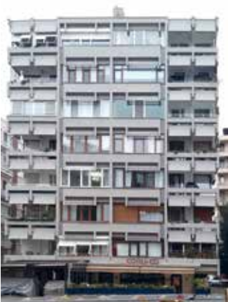
Resim 6. 1970'li yıllarda, Moda'da konut dokusuna örnekler. Sırasıyla; İbrahim Paşalıoğlu tasarımı Nil Apartmanı, Melih Koray tasarımı Mehtap Apartmanı, Şadi Adıgüzel tasarımı Babadan Apartmanı ve Altuğ-Behrüz Çinici tasarımı Subaşı Apartmanı (Yazar arşivi).
