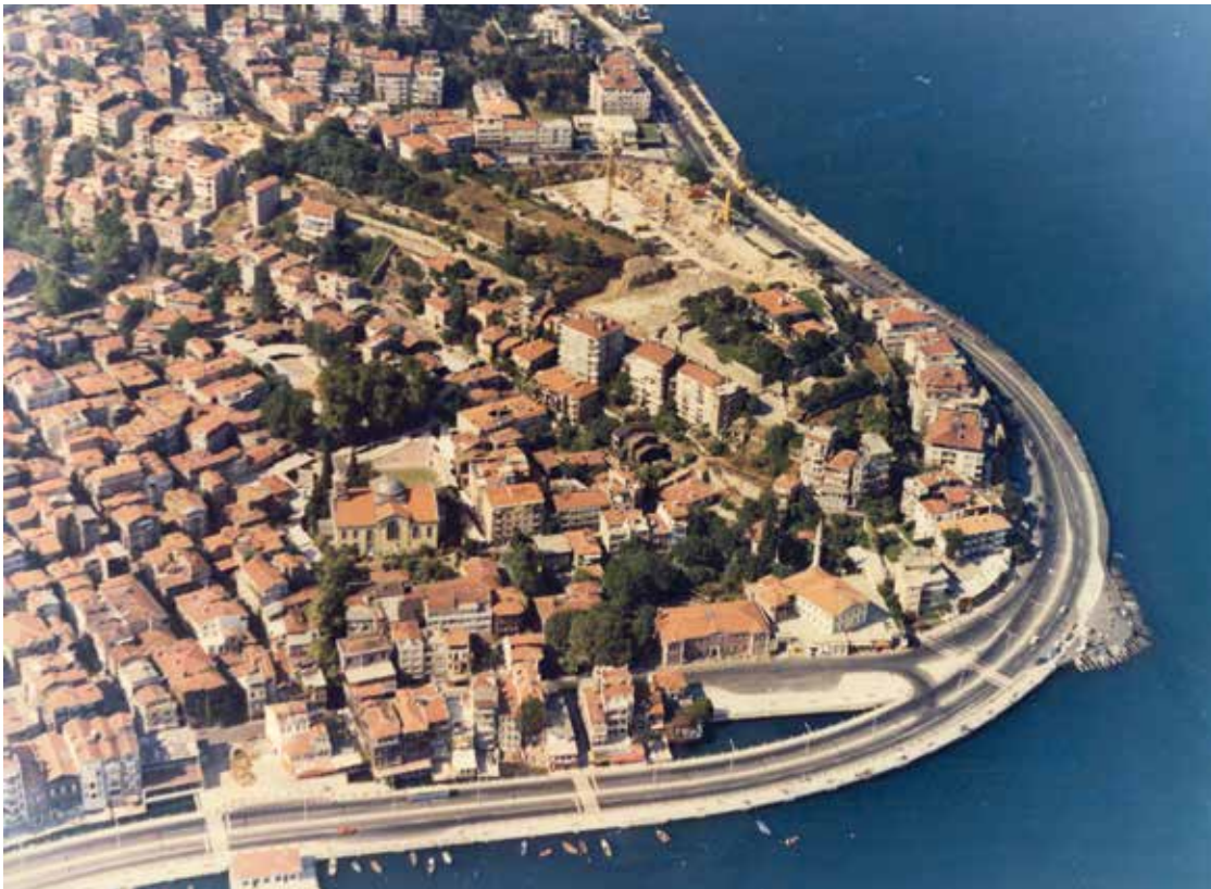
Şekil 5: Kuruçeşme- Arnavutköy arasına inşa edilen 'kazıklı yol'.
