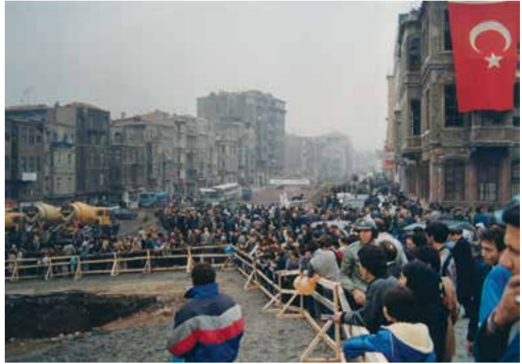
Şekil 4. Tarlabası Bulvarı'nın inşası çalışmaları.
