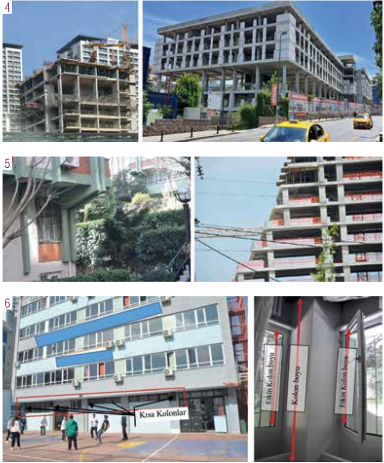
Resim 4. B1-zayıf kat ve B2-yumuşak kat oluşumlarına örnekler (İstanbul).
