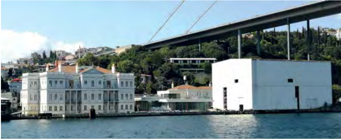
Resim 9. 2002 yılındaki kısmi yangın (Gaziosmanpaşa İlkokulu) sonrasında lüks bir otel olarak yeniden inşasına başlanan Ortaköy'deki Fehime ve Hatice Sultan Yalıları ve ek yapıları 27 (2022).
