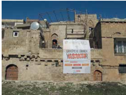
Resim 1. Tamirevi güney cephesi.
