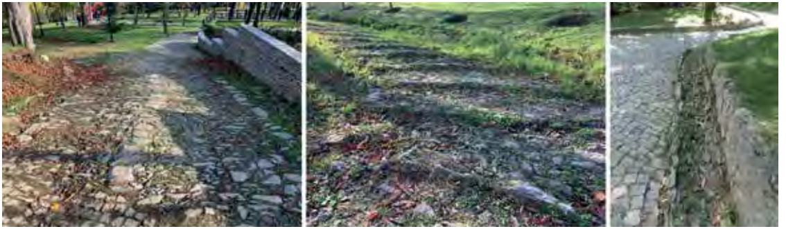
Şekil 9. Solda, korunabilmiş özgün döşeme, ortada aynı döşemenin eğimli alanlarda kademelendirilmiş hali; sağda, yol döşemesi değiştirilmesine rağmen korunabilmiş özgün yağmur kanalı ve bordür.
