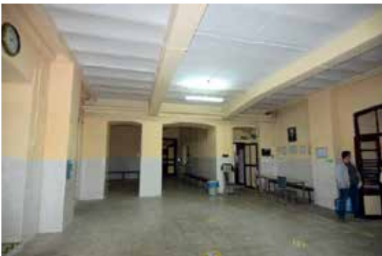
Resim 20. Birinci kat tören salonunun tavanında görülen iki parçalı kirişler (proje grubu, Şubat 2021).
