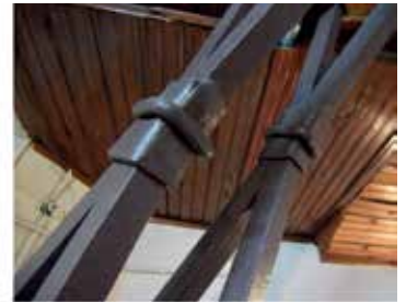
Resim 24. İkinci katta, kulenin altındaki mekânda, X şeklinde, iki adet, 6x6 cm. boyutlarında kare kesitli demirden oluşan çifte payandalar (24.02.2021, Ö. Dabanlı).
