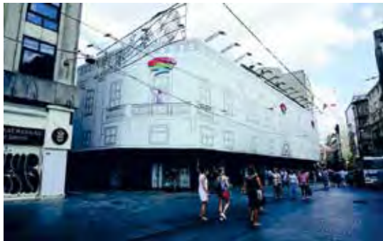
Resim 19. Yapının restorasyon için kapatılmış cephesi (Neumeier, 2014:36).
