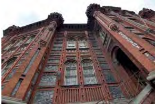
Resim 21. Güney cephesi. Planda birbirini kesen dik duvarlar köşegeni doğrultusunda dış doğru genişleyerek köşeleri sağlamlaştıran birer payanda görünümü almaktadır (24.02.2021, Ö. Dabanlı).
