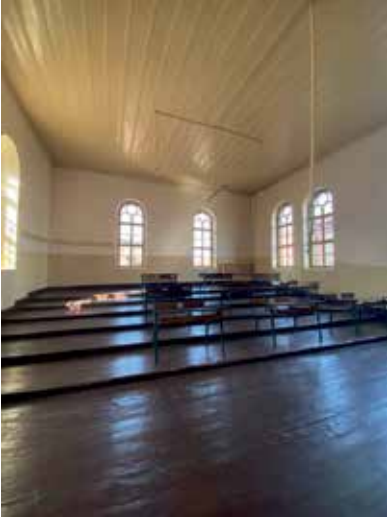
Resim 10. Birinci kat batı kanadı ucunda yer alan amfi. Sınıfta tavan ve yerde ahşap kaplama görülmektedir (proje grubu, Kasım 2020).
