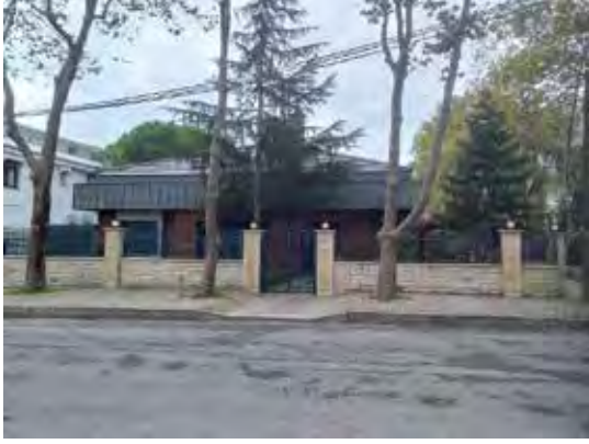
Şekil 12. Hava Evleri, yeniden inşa edilmiş bir örnek.
