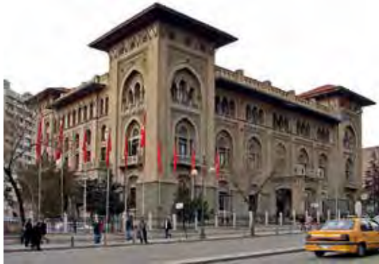
Resim 1. Ziraat Bankası Genel Müdürlük Binası, Mongeri, 1926-1929 (Url 1).
