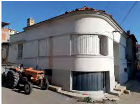
Şekil 9. Konut C, Derman Sokak No: 1. Derman Sokak ile Dönemeç Sokak’ın kesişiminde olan yapının dairesel cephesi adeta sokağa ismini vermiş gibidir.
