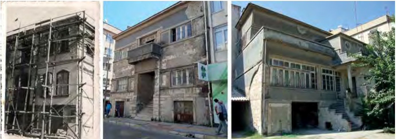
Şekil 10. Konut D, sol taraftaki fotoğraf evin Yunan işgalinden sonra onarılma aşamasını göstermektedir. Konutun güncel fotoğrafında ise (ortada ön cephe, sağda avluya açılan arka cephe görülmektedir), bu onarımdan sonra 1945 senesinde değiştirilen cephenin sökülmiş sıvalarının altında, kapatılan pencere hizaları ve boşlukları tuğla dolgu olarak izlenebilmektedir.
