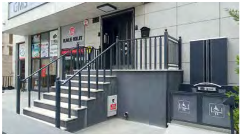
Resim 1. Açık asansör ile giriş kotuna erişim (Fotoğraf: Selhan Yalçın Usal, 2019).
