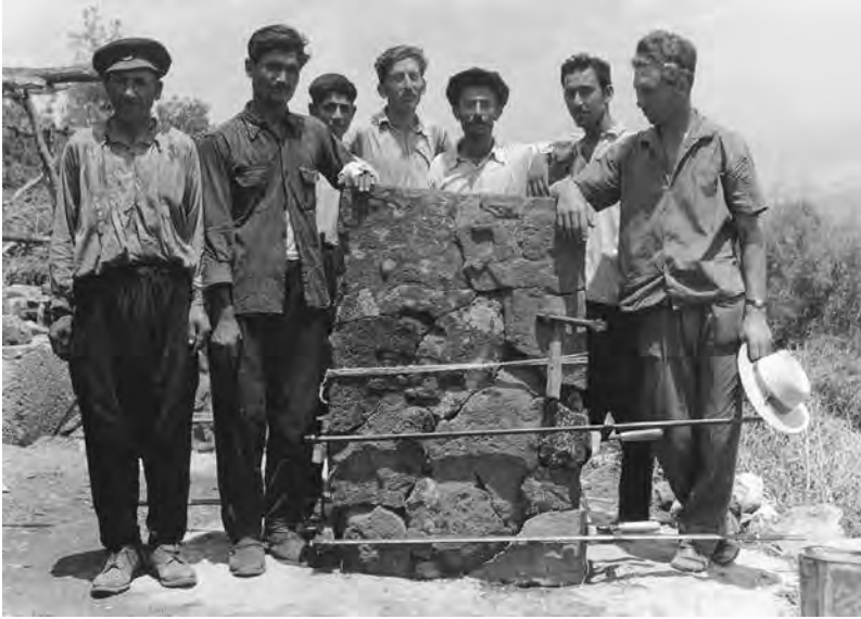
Resim 12. Anastylis uygulamalarında kullanılan pirinç çubuk ve yapıştırıcıya bir örnek (Temmuz 2018).
