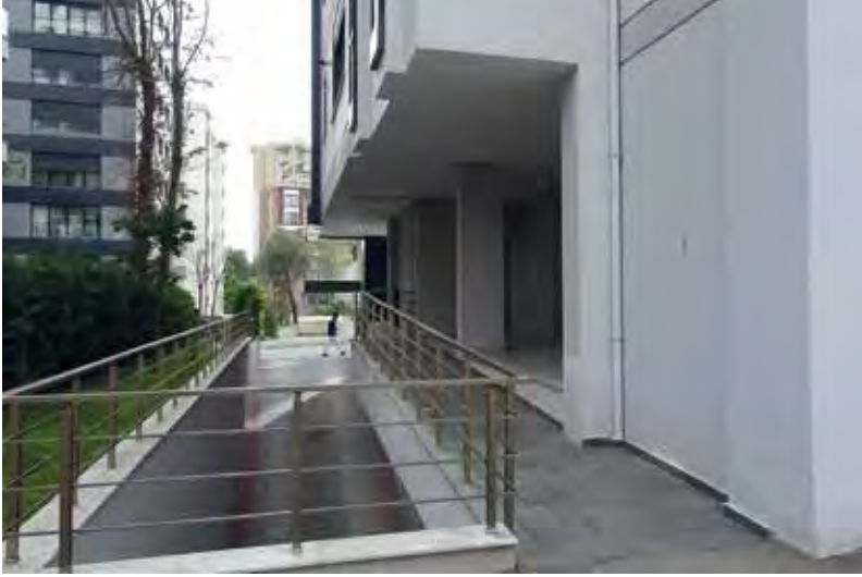
Resim 2. Bina girişinde rampa yapılmadan sadece otoparktan rampayla giriş kotuna erişimin sağlanması. (Fotoğraf: Selhan Yalçın Usal, 2019).
