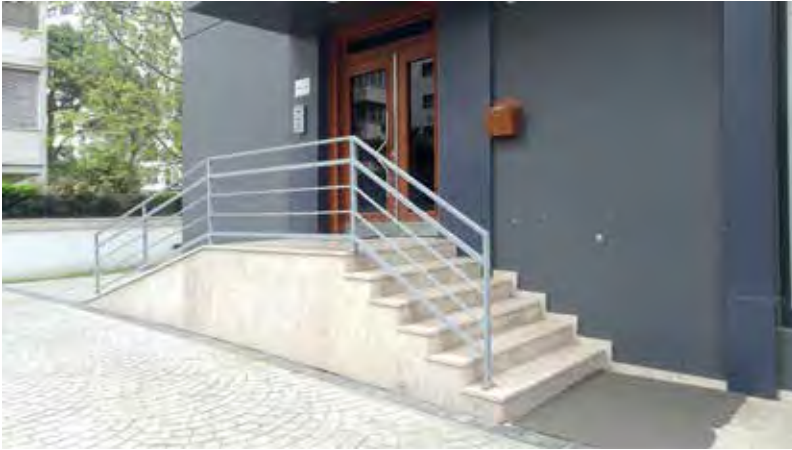
Resim 3. Uygun olmayan eğimde yapılmış rampa (Fotoğraf: Selhan Yalçın Usal, 2019).
