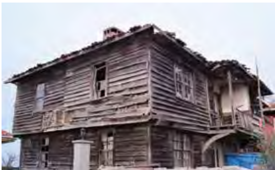
Resim 29. Sofa uçlarındaki balkon payandası.
