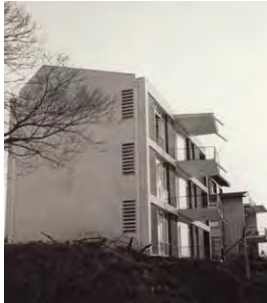
2. Esat Mahmut Karakurt Apartmanı (1956, Mahmut Bir ile). Cephede strüktür çözümlenmesi denemeleri, taşıyıcı strüktür, koruyucu duvar ve boşluğun kuruluşu (Salt Araştırma Utarit İzgi Arşivi).
