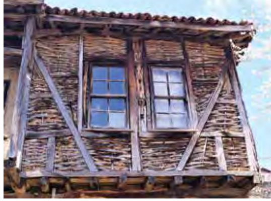
Resim 23. Ahşap çatki arası sepet örgü dolgu tekniği.
