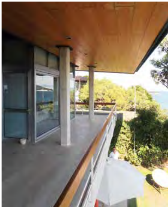
11. Yapıdan koparılarak ayrıca asılan saçak, teras ilişkisi (Nezih Aysel, 2018).
