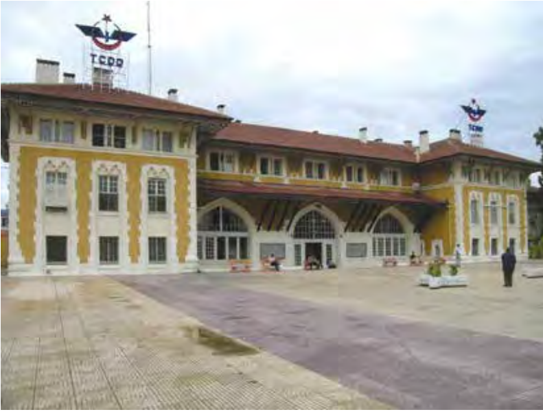
Resim 7. Adana gar binasının caddeye bakan cephesi, 2006.
