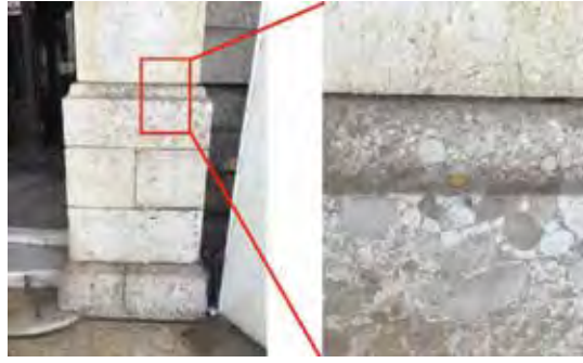
Resim 4. Temelde de kullanılmış olduğu saptanan hereke pudingi, yapının güneydoğusunda giriş kapısı kenarlarındaki sütun kaidelerinde kaplama taşı olarak da kullanılmıştır.
