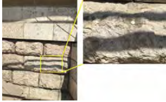
Resim 5. Gar binasının alt kesimlerinde hereke pudinglerinin hem kaplama taşı, hem de işlenmiş blok olarak kullanıldığı yerler de mevcuttur.
