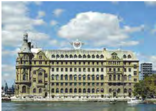
Resim 3. Haydarpaşa gar binası doğu cephesi. Philipp Holzmann inşaat konsorsiyumu tarafından 20. yüzyılın ilk yıllarında tipik bir Wilhelm dönemi yapısı olarak inşa edilmiştir.
