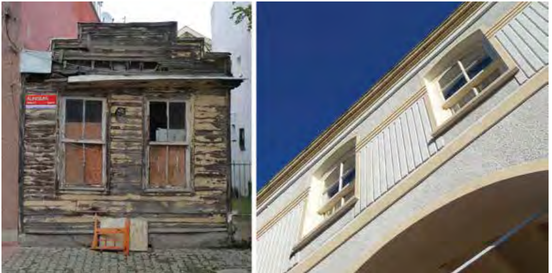
Resim 4. Özgün örnekler: a. Alpaslan Sokak, Büyükkada, ahşap taşıyıcı sistemle inşa edilmiş art deco yapı. b. Saat Meydanı, Büyükkada, art deco'ya bürünmüş 19. yüzyıl yapısı.
