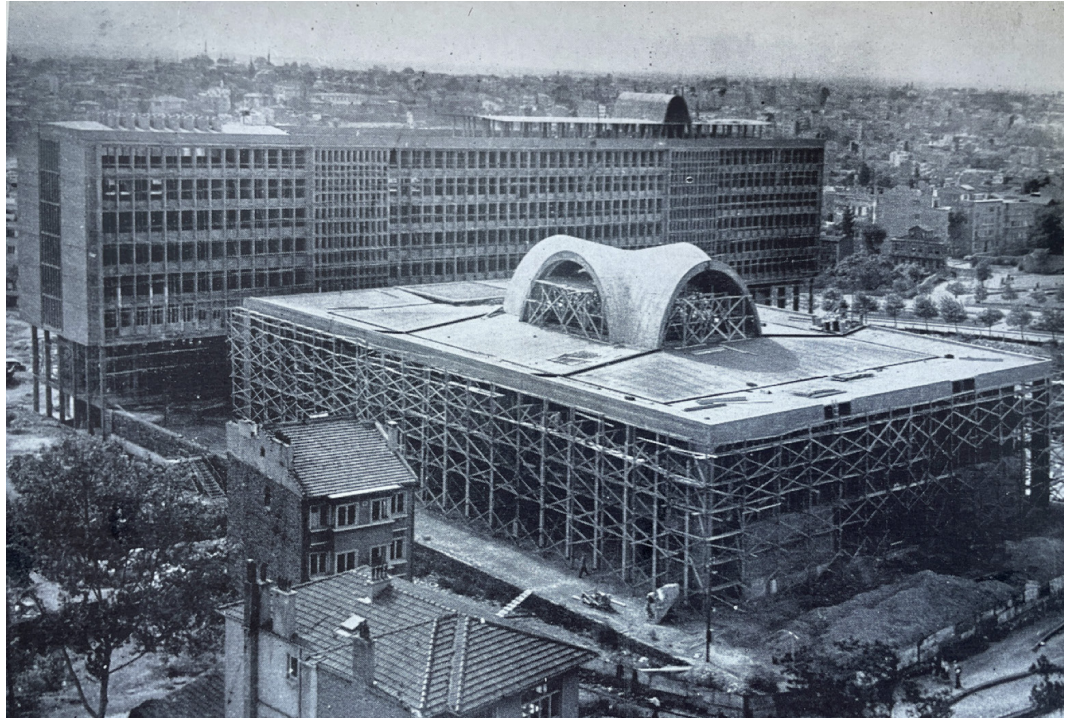
Resim 11. Yapının inşaat süreci (İstanbul Valiliği (1957). İstanbul'un Kitabı, İstanbul)
