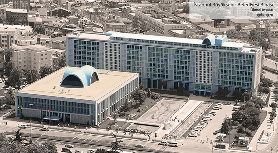
Resim 14. İstanbul Belediye Sarayı genel görünüm ( https://www.imar.istanbul/tr/proje/istanbul-buyuksehir-belediyesi-binasi )
