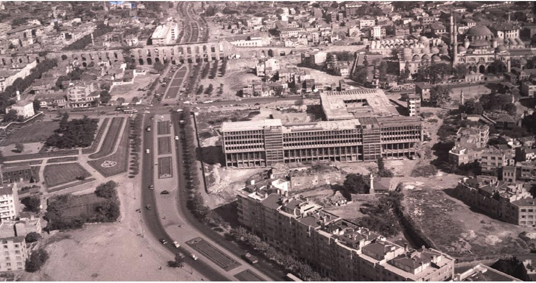
Resim 2. Saraçhane Belediyesi inşaatını gösteren hava fotoğrafı, 1954-59 (İBB, t.y.).
