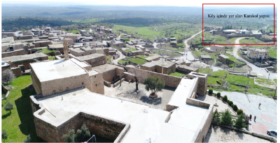
Resim 9. Haberli Köyü içinde yer alan Karakol yapısı.
