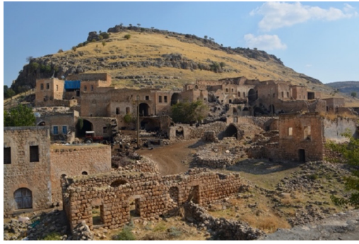
Resim 12. Dereiçi Köyü sivil mimari yapıları.
