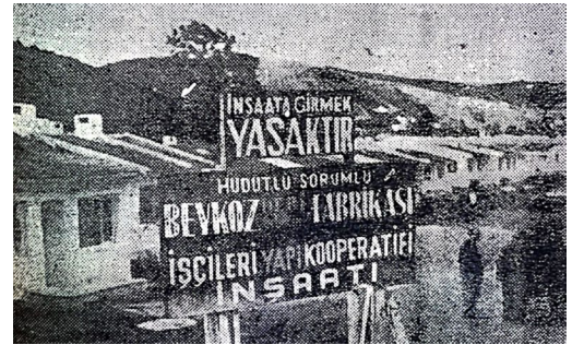
Resim 6. Beykoz Deri Kundura Fabrikası İşçileri ikinci kooperatif yerleşimi inşaat aşamasında (Fotoğraf: Savaş Dik, içinde: Ekinci, 1964)
