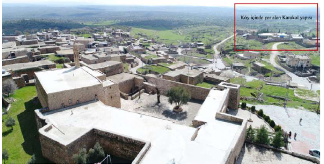
Resim 9. Haberli Köyü içinde yer alan Karakol yapısı.
