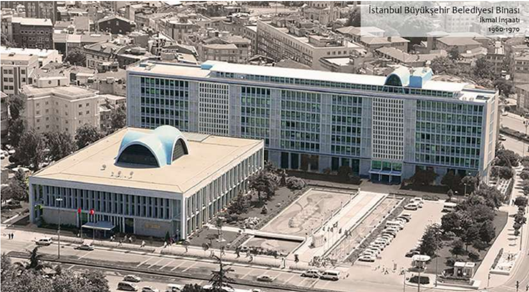
Resim 14. İstanbul Belediye Sarayı genel görünüm ( https://www.imar.istanbul/tr/proje/istanbul-buyuksehir-belediyesi-binasi )
