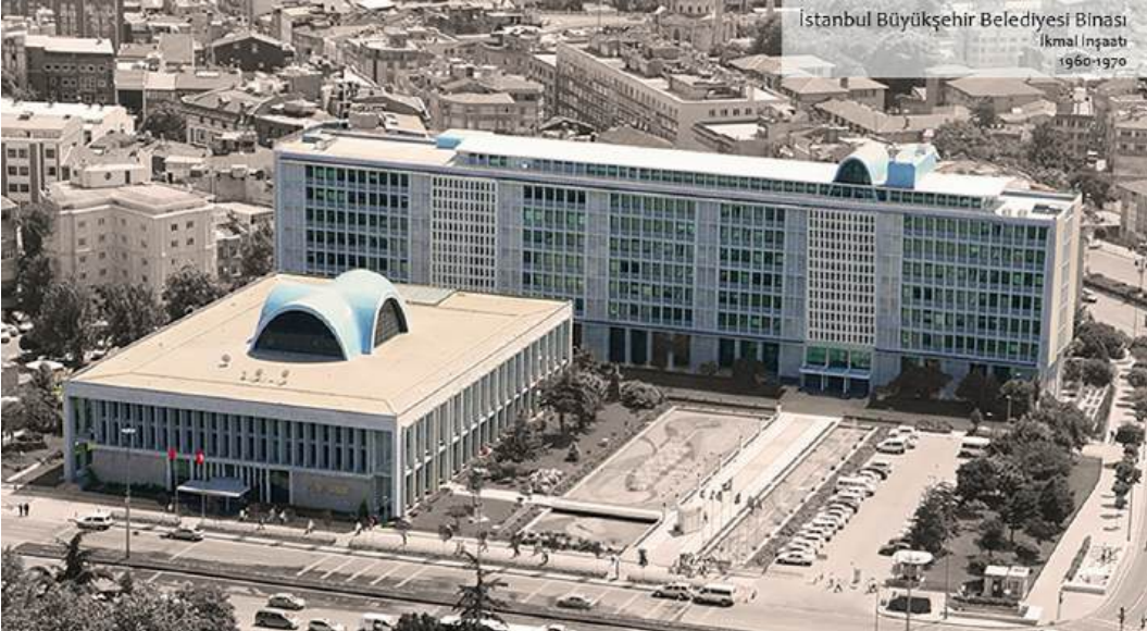
Resim 14. İstanbul Belediye Sarayı genel görünüm ( https://www.imar.istanbul/tr/proje/istanbul-buyuksehir-belediyesi-binasi )
