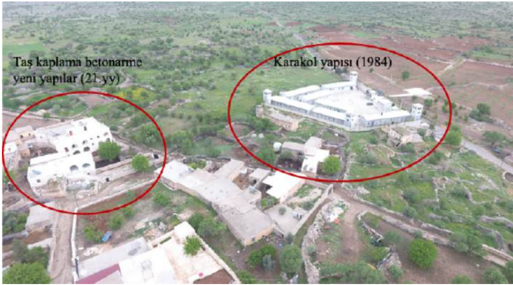
Resim 5. Karakol yapısı ve yeni yapılan yapılar.
