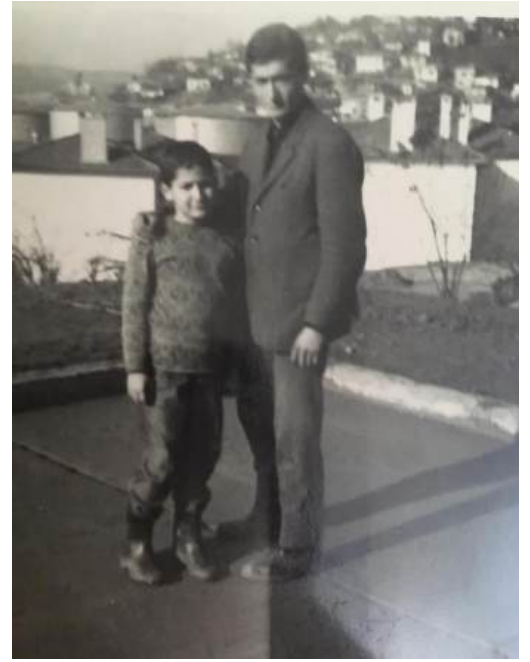
Resim 16. 1960'larda kooperatif ortağı işçinin oğlu, sonradan oturacakları evin inşaat sahasında şantiyede görevli usta ile. Arkada ilk etapta tamamlanan evler, onun arkasında Beykoz Shell Depoları ve onun da arkasında Karlıtepe sırtlarında gecekondular. (Fotoğraf: Anonim. Bülent Gür Arşivi'nden izinle kullanılmıştır)
