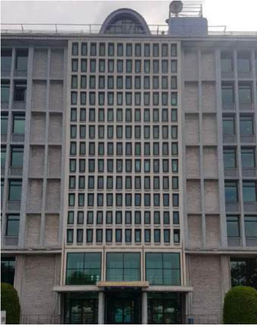
Resim 17. Ofis bloğunun giriş saçağı ve cephesi (Yazarların arşivinden, 2017)
