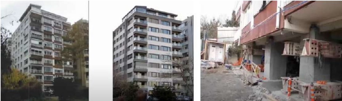
Resim 11. Mantolama ve izolatör ile güçlendirilmiş betonarme konut yapısı ( https://ulkermuhendislik.com.tr/blogDetay.asp?id=4630&t=Binam-Deprem-Yalitimi-sismik-izolasyon-ile-Guclendirilebilir-mi- )
