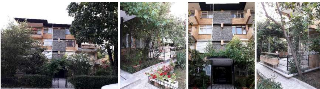
Resim 6. Seden Apartmanı ve bahçesi (Yazarın arşivinden).
