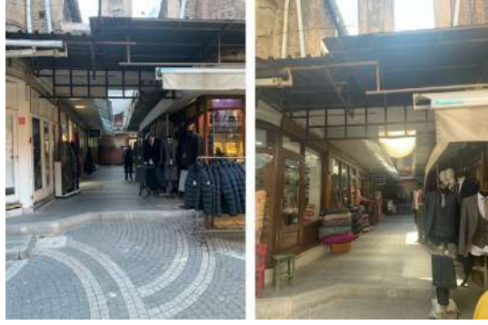
Resim 14. Camlı Bedesten günümüzde giriş ve camekanlı zemin kat cephesi (Yazar arşivi).
