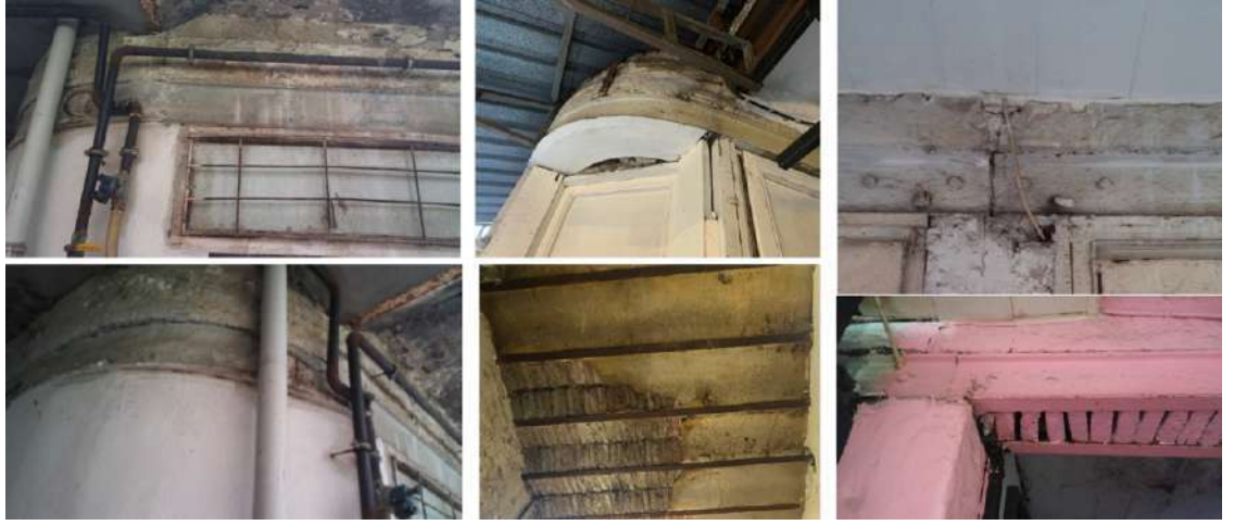
Resim 19. Yapının ana strüktüründe kullanılan metal elemanlar/ putrellerin üzerindeki yerleri (Yazar arşivi).
