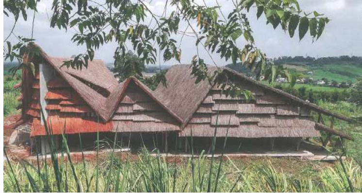
Resim 5. Lam Son, çok amaçlı sosyal merkez binası güney cephesi.
