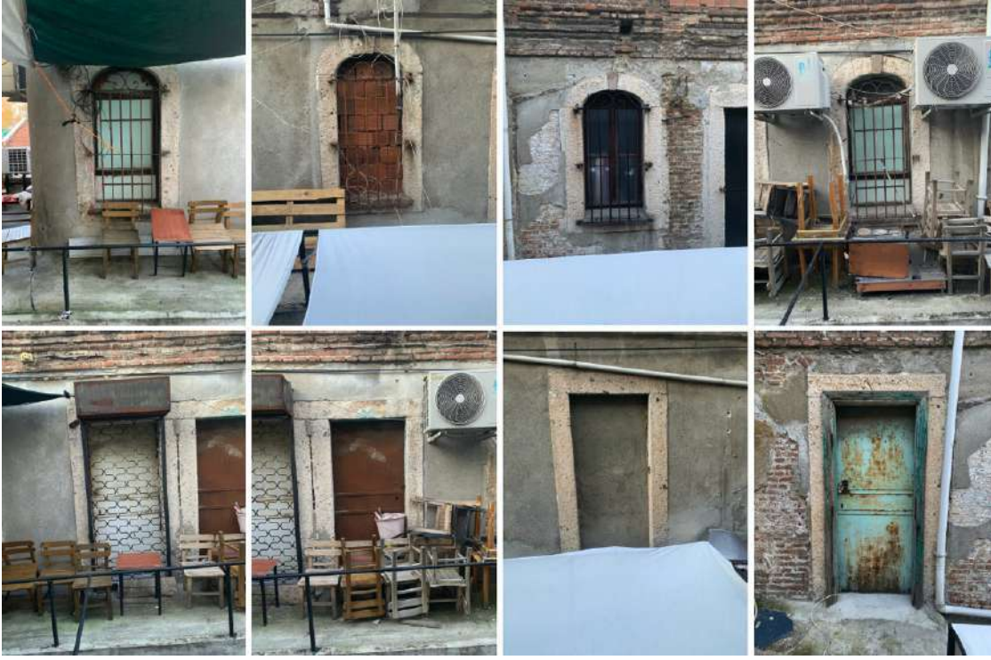
Resim 16. Birinci kattaki kapatılan veya değiştirilen kapı-pencere örnekleri (Yazar arşivi).
