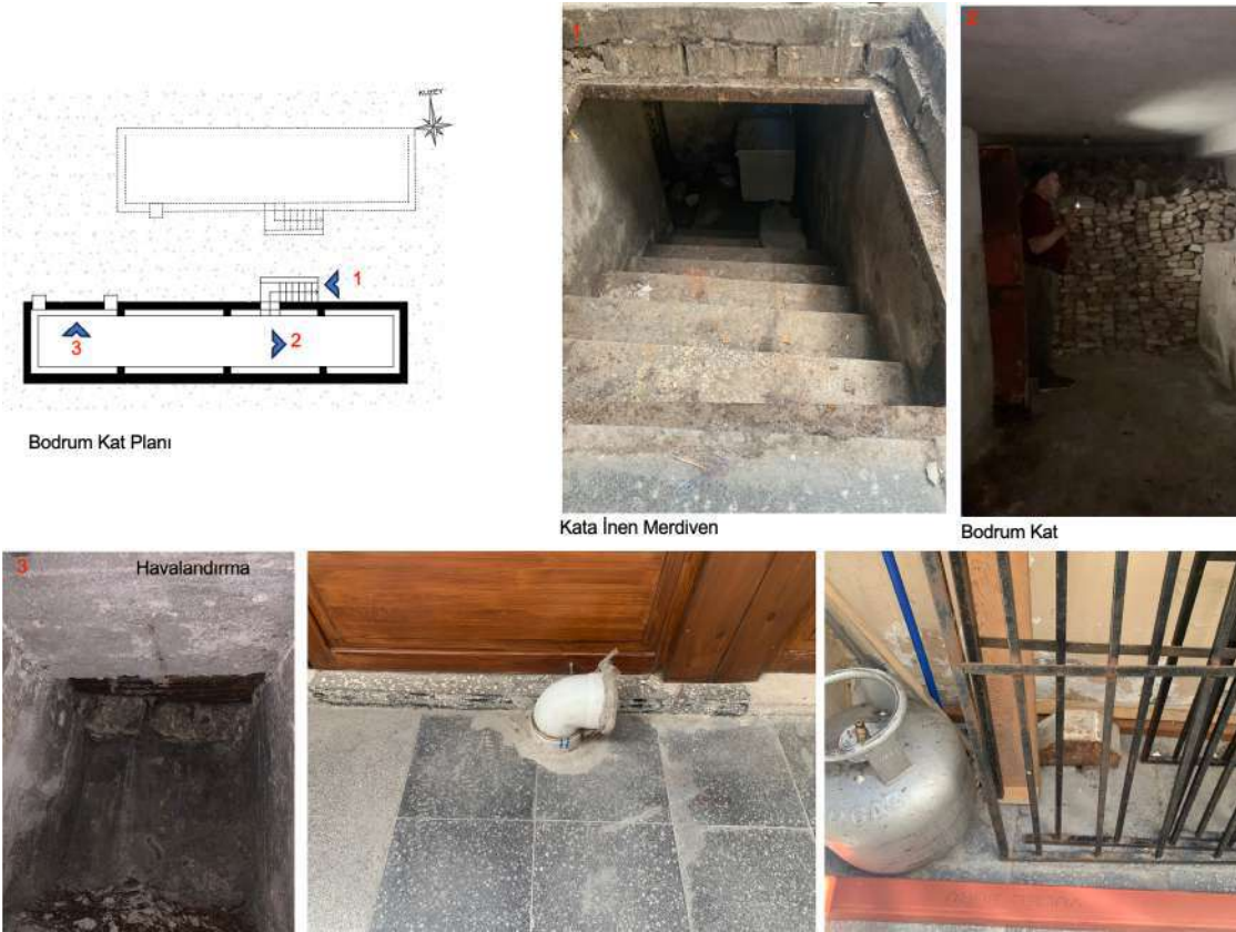
Resim 8. Camlı Bedesten bodrum kat detayları (Yazar arşivi)
