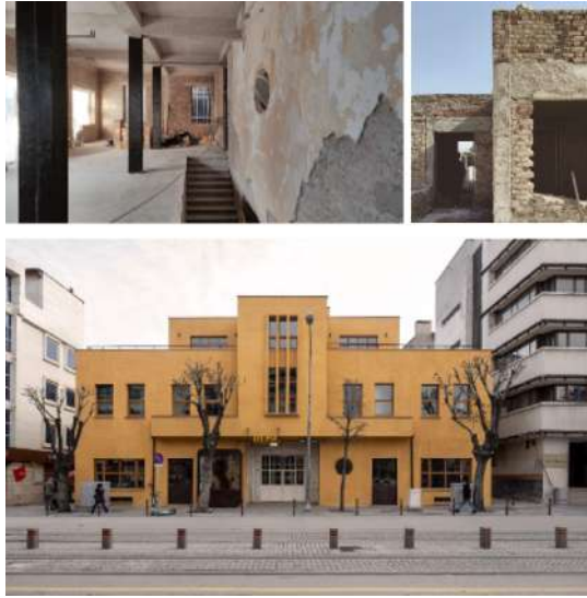
Resim 12. Konya Tekel Binası (Yalın Mimarlık Arşivi).
