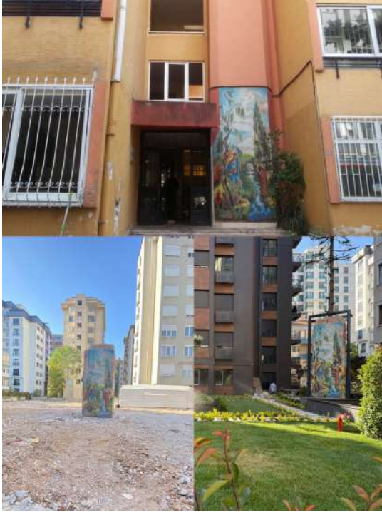
Resim 2. Kadıköy, Suadiye, Aydın Sokak, İzmir Apartmanı.
